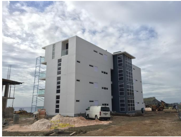
Gebouw C- verwachte oplevering Jan-Feb 2018
